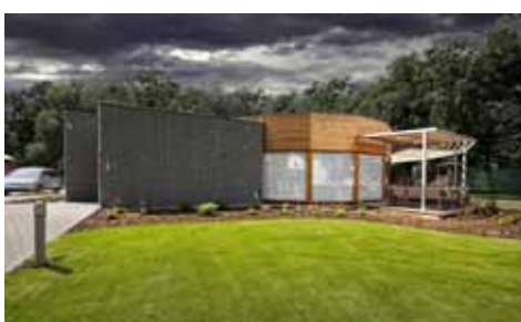
Cena novinářů: Lanové centrum Otrokovice. Příhlašovatel: Navláčil stavební firma
