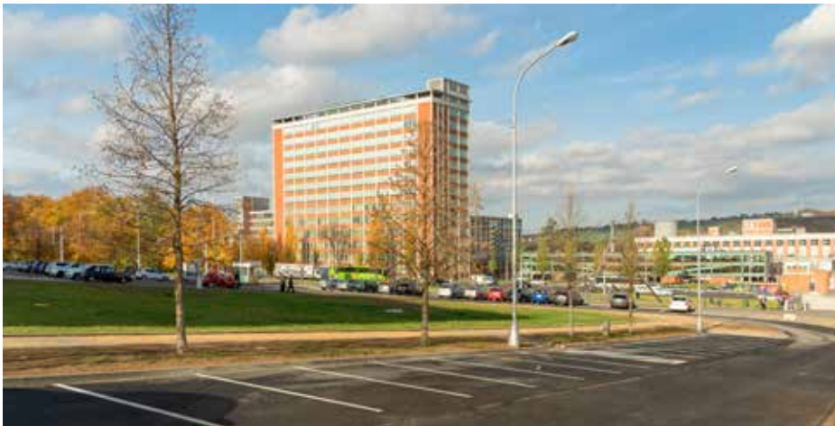
► Takový pohled se moc často nenaskytne. Jen krátce po dokončení stavby. Foto: Tomáš Novosád
