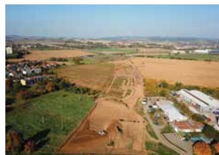
► Letecký záběr stavby D55, obchvat Otrokovice.
