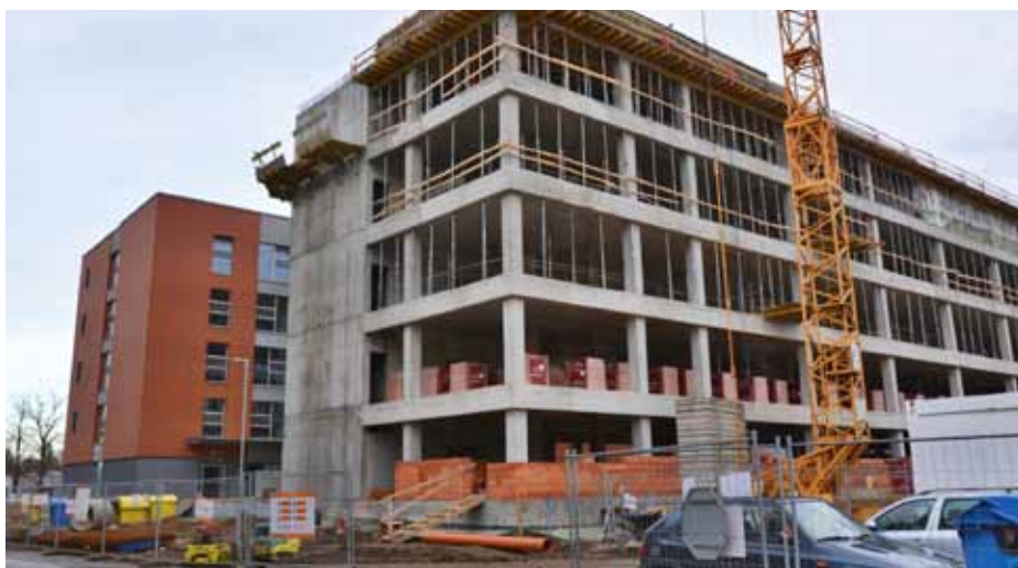
► Stavbaři finišují s hrubou stavbou interny. Foto: Uherskohradištská nemocnice
