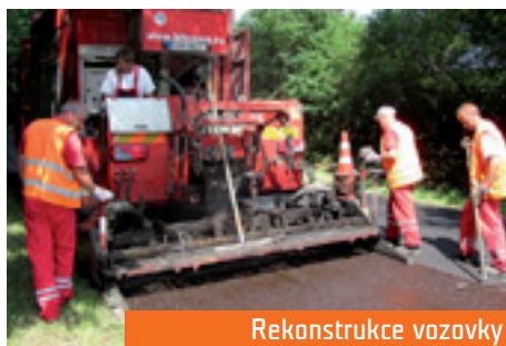
Silnice u Šarova
