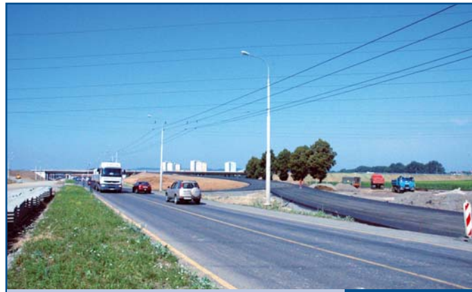
Významnou stavbou je obchvat Otrokovic.
