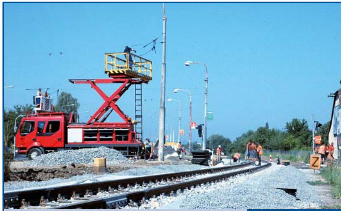
Překládka železniční trati kvůli rozšíření silnice 1/49.
