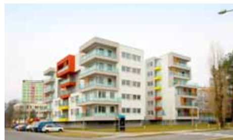
Bytový dům Otrokovice
