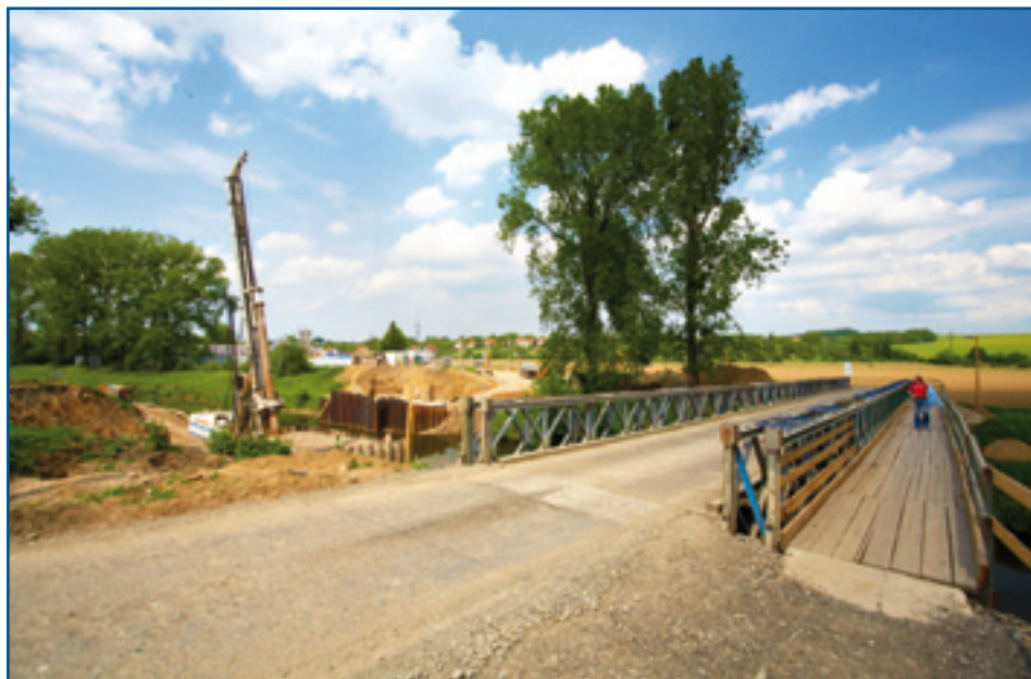
Práce na výstavbě nového mostu ve Zlíně-Malenovicích jsou v plném proudu. ■ foto: Ivo Hercík
