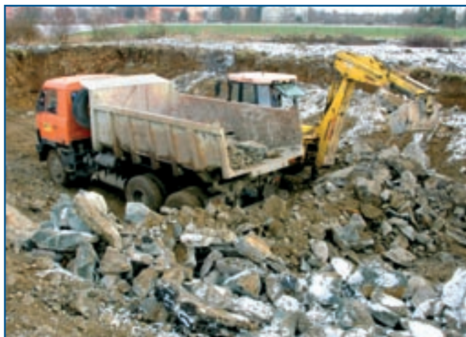
Práce na bourání prvních objektů a likvidaci zpevněných ploch v prostorách budoucí Strategické průmyslové zóny Holešov byly zahájeny. První investoři zamíří do průmyslové zóny v roce 2010. (jjn) foto: Ivo Hercík
