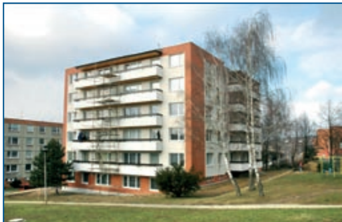
Rekonstrukce panelového domu na Jižních svazích.
