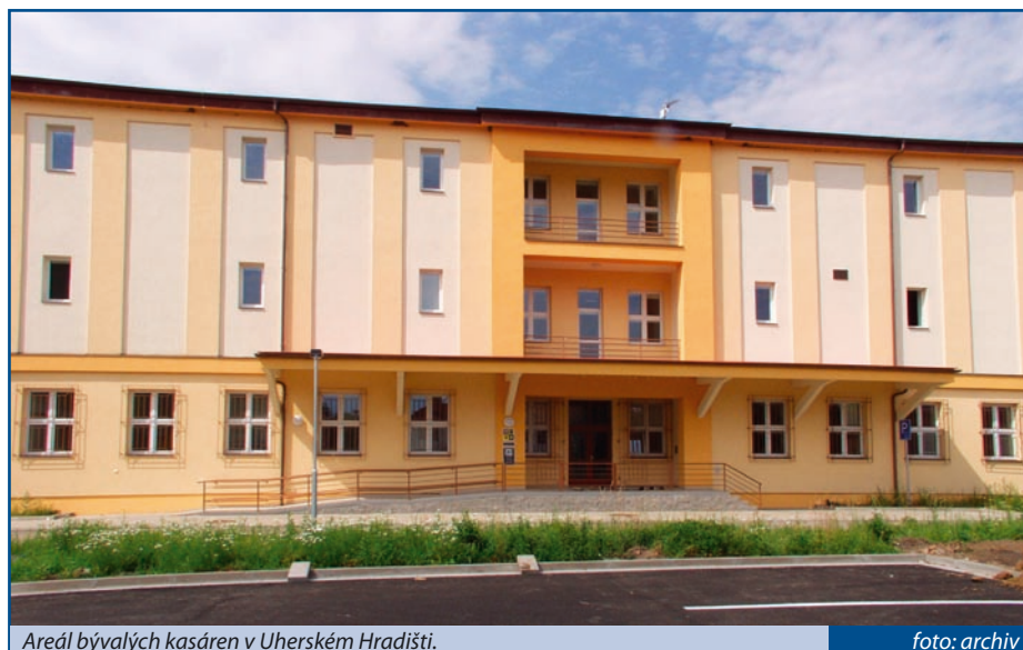
Areal bývalých kasáren v Uherském Hradišti.
